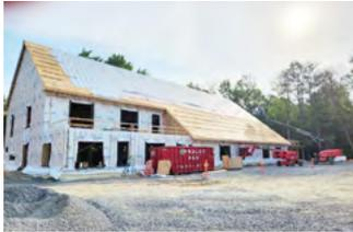
Malgré les hauts et les bas de la météo, les travaux avancent bien. **Le toit a été complété ainsi que l'installation de la membrane** pour l'étanchéité avant la pose de la tôle.
