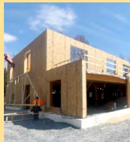
Murs préfabriqués isolés montés au rez-de-chaussée et à l'étage!
