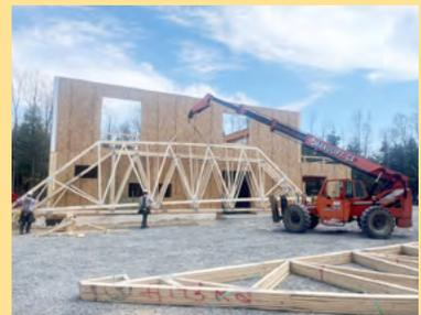
Montage des fermes de toit en section.
